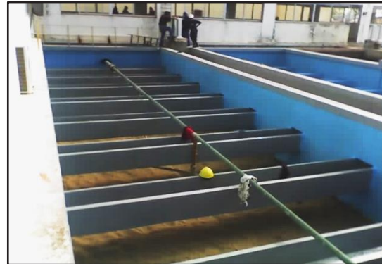
Instalando revestimiento ARC S1PW .
